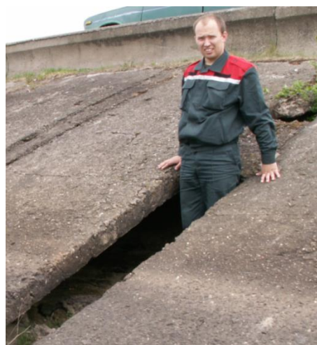
Вывос грунта из-под плит крепления откоса на вдхр. Млынок
